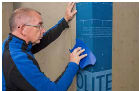
PRESSFIX XL Ermöglicht das einfache und schnelle Anpressen von SOLITEX ADHERO 1000/3000
