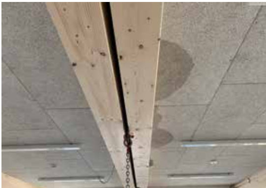
Undichter Modulstoß
